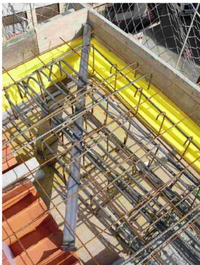
Detalle instalación esquina
