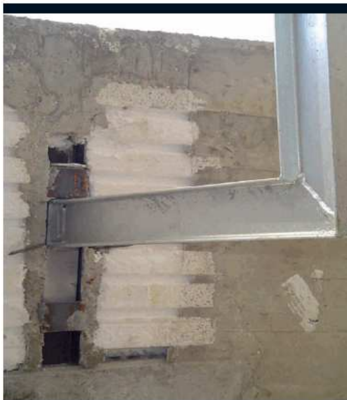
Detalle de anclaje
