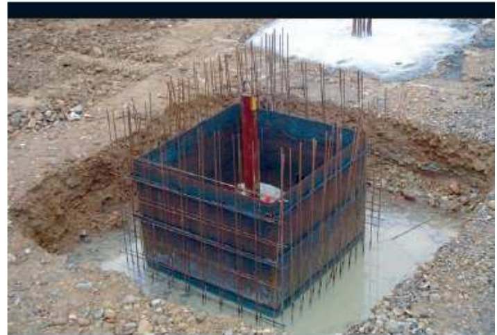
Foso de ascensor
