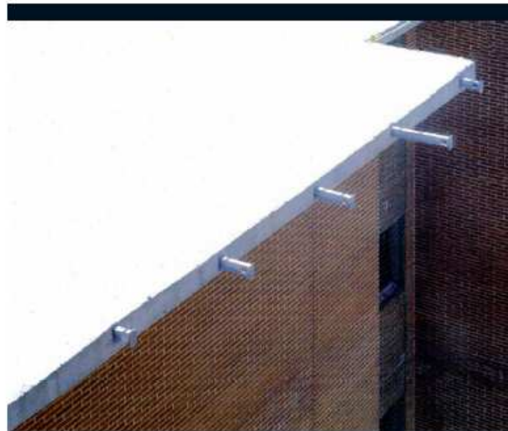
Detalle soporte retráctil extendido
