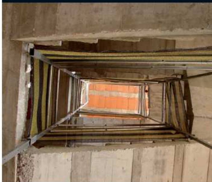
Escalera vista desde arriba
