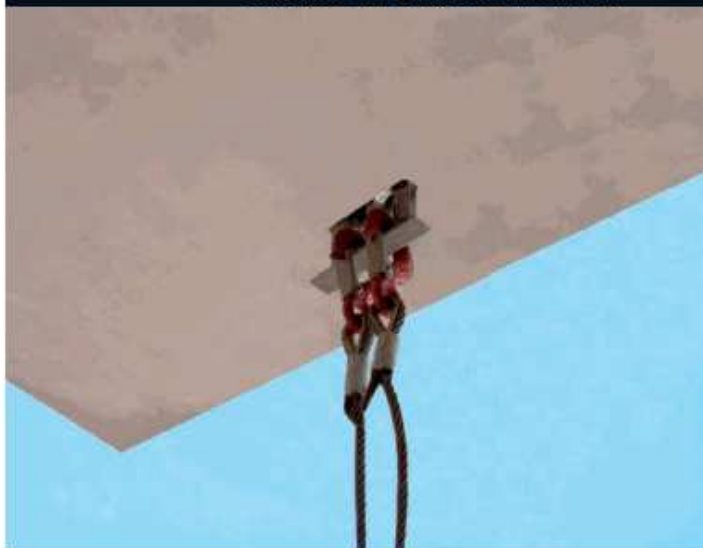
Anclaje bajo alero colocado
