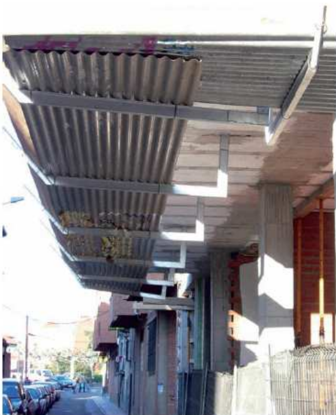
Instalación de marquesina
